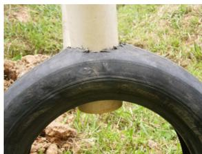
11. Detalhe da entrada da tubulação de esgoto, atravessando o pneu
