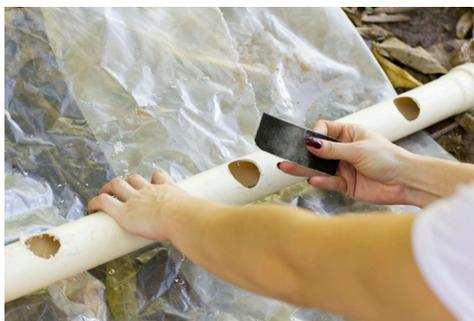
**19.** *Detalhes dos furos do tubo dreno. A parte inferior do tubo tem furos e é envolvida por tela tipo mosquiteiro ou saco de cebola*
