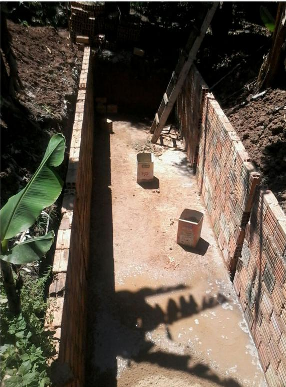
6. *BET em construção. Foram utilizados blocos cerâmicos para as paredes e o piso recebeu tela pop e concreto*
