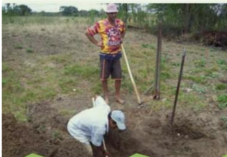
Sondagem no local onde será construída a barragem Foto: ASA
