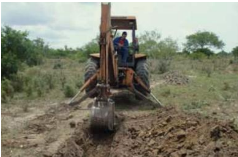
Escavação com máquina Foto:ASA
