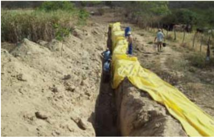
Colocação da lona plástica Foto: ASA
