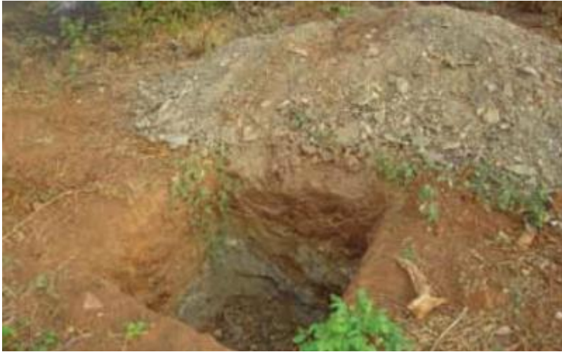
Sondagem para localização das ombreiras Foto: ASA
