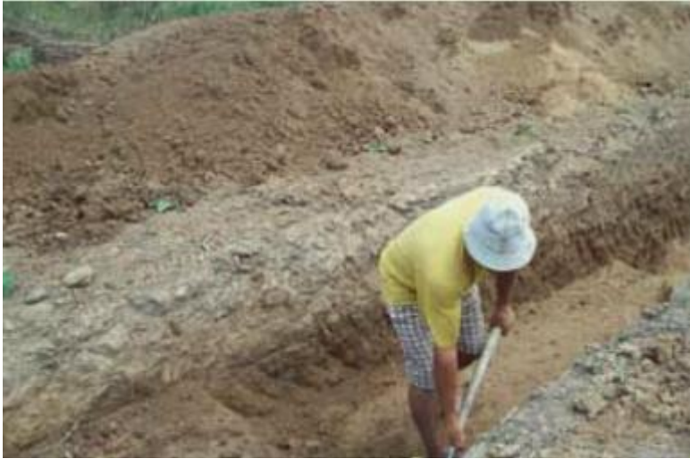
Escavação manual Foto: ASA
