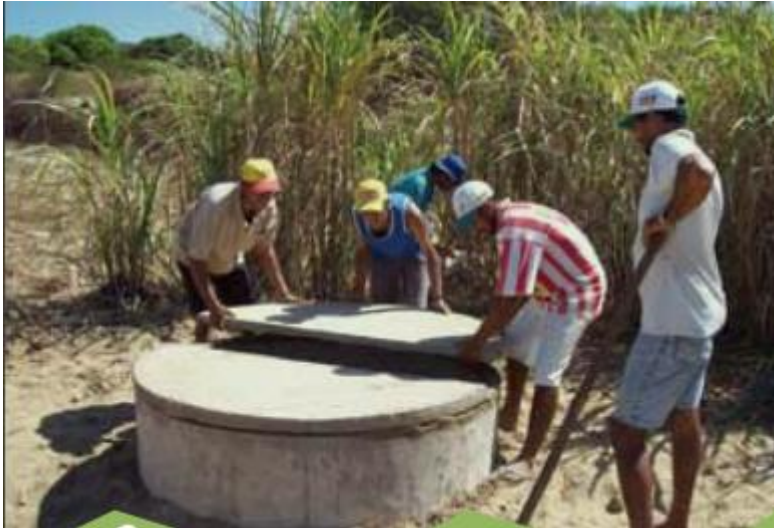
Pedreiros finalizando a construção do poço Foto: ASA
