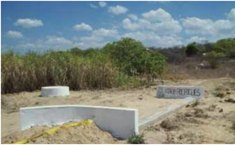
Sangradouro é construído para aguentar pressão da água, fazendo com que a barragem não estoure. Foto: ASA
