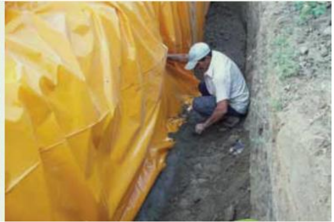
Chumbamento da lona com cimento Foto: ASA
