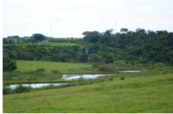
**Figura 2.** Estabilização de voçoroca com construção de quatro açudes em desnível no Polo Regional do Centro Norte/APTA, Pindorama (SP). Fonte: Adaptado de Abdo et al. (2013).
