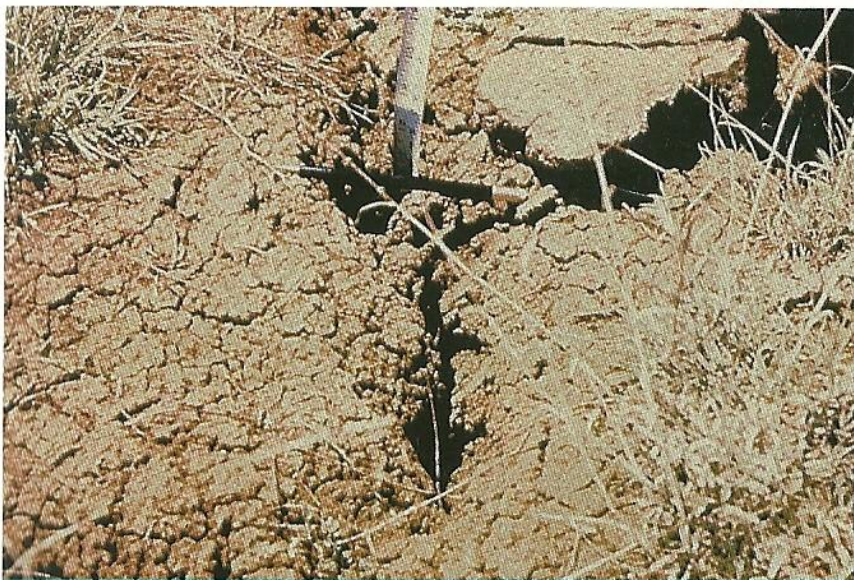
Aspecto das rachaduras provocadas pela secagem das argilas expansivas do Vertisol (Vertissolo)
