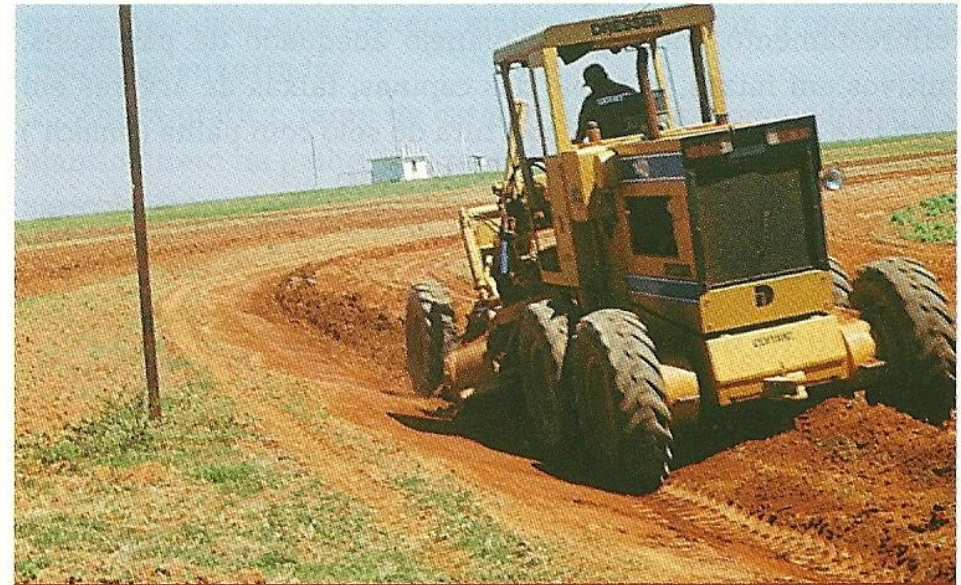
Para a execução das práticas de caráter mecânico, é necessário um planejamento adequado para localizá-las e orientar a direção dos canais e camalhões dos terraços construídos pelas máquinas
