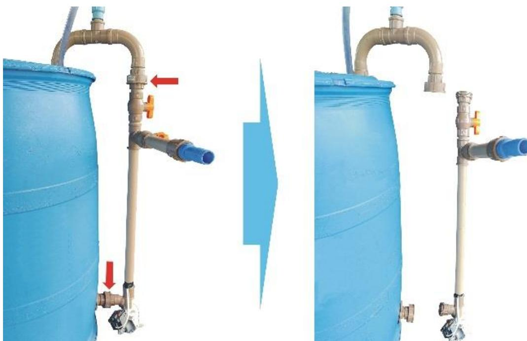
**Figura 27.** Destacando a bomba elétrica para lavagem do sistema.
